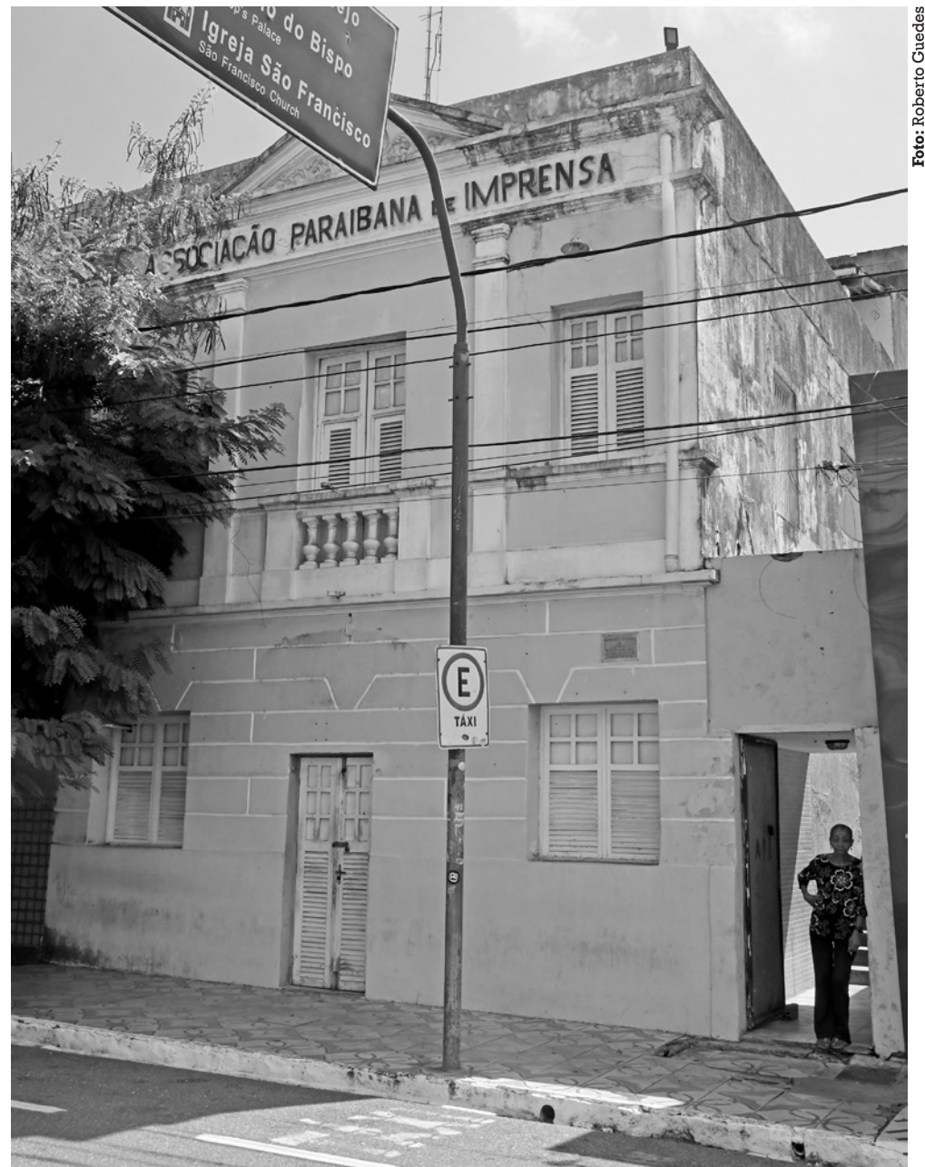
Prédio sede da Associação Paraibana de Imprensa, na Rua Visconde de Pelotas, Centro
